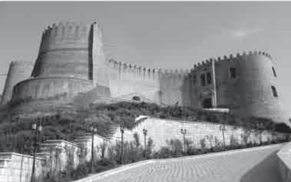
خرم‌آباد. قلعه‌ی فلک‌الافلاک
