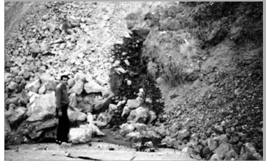
تصویر ۸. ظهور چشمه جدید در محل لغزش و پس از حرکت توده
