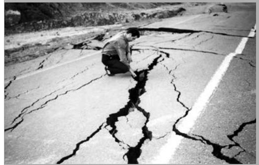
تصویر ۹. ایجاد شکستگی‌های فراوان در جاده جابه‌جا شده شامل دو نوع شکستگی کششی موازی با جاده (۱) در نتیجه حرکات کششی و شکستگی‌های برشی عمود بر جاده (۲) ناشی از اختلاف میزان حرکت دو طرف شکستگی
