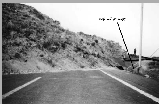
تصویر ۵. جابه‌جایی جاده همراه با توده لغزش یافته
