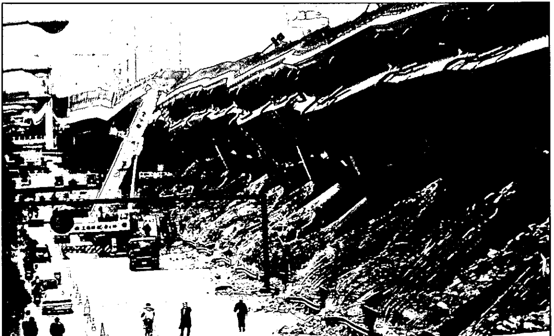
شکل ۳- پایان کار راه سریع السیر چر تعلق عظیم مشغول بیرون کشیدن اتومبیلها از آوار «هنشین» است راه سریع السیر «کوبه» ژاپن
