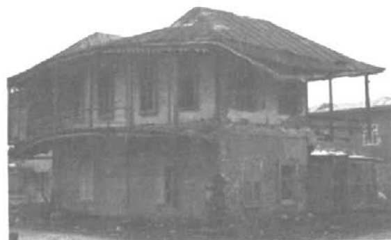
تصویر ۱۵: نمونه‌ی از خانه‌ی قدیمی در حال تخریب
