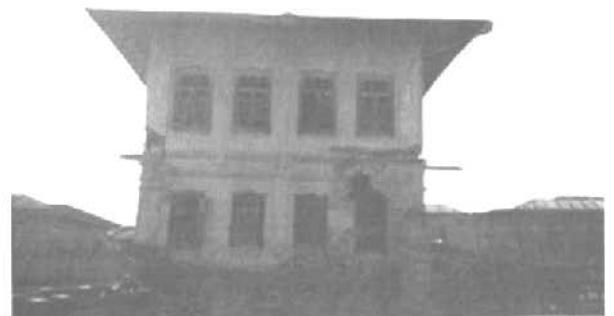
تصویر ۱۴: نمونه‌ای از خانه‌ی قدیمی در حال تخریب
