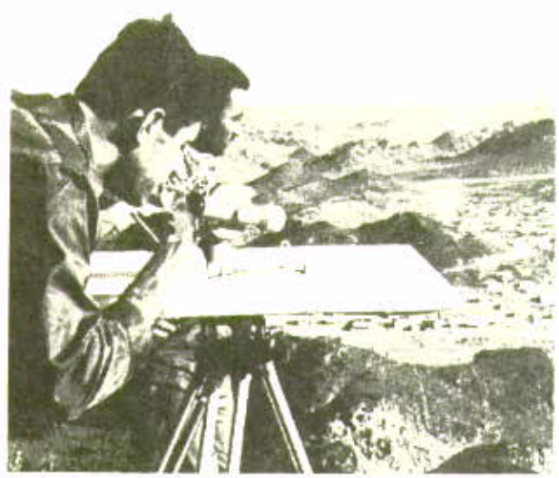
شکل ۲ - نقشه‌برداری با وسیله تریپد
